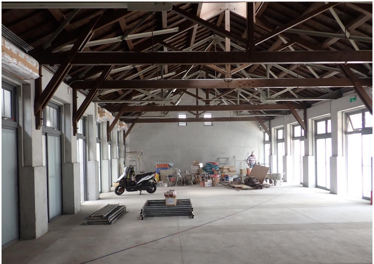
香蕉倉庫西側室內修復後(20210412)
