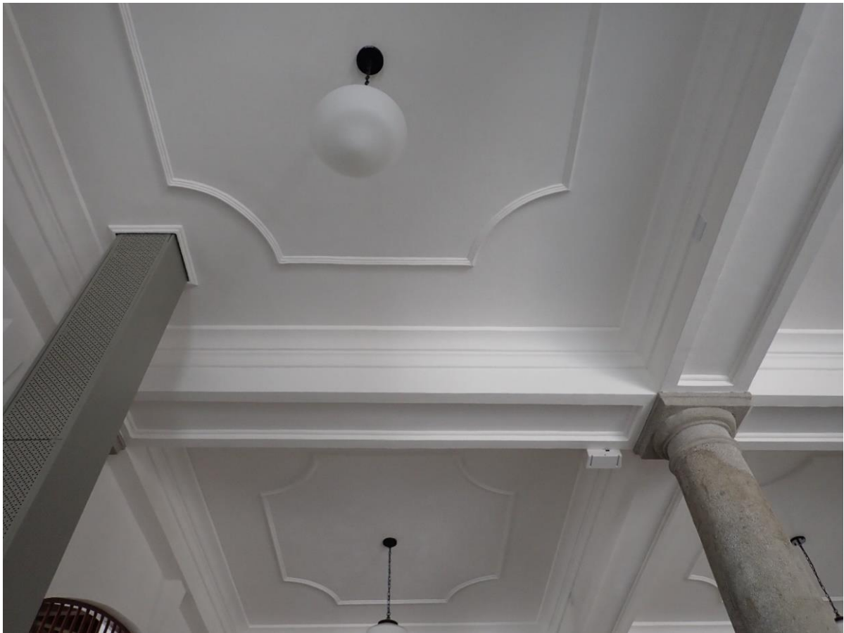
西市場本館-中央棟西南側立面入口修復後(20210412)
