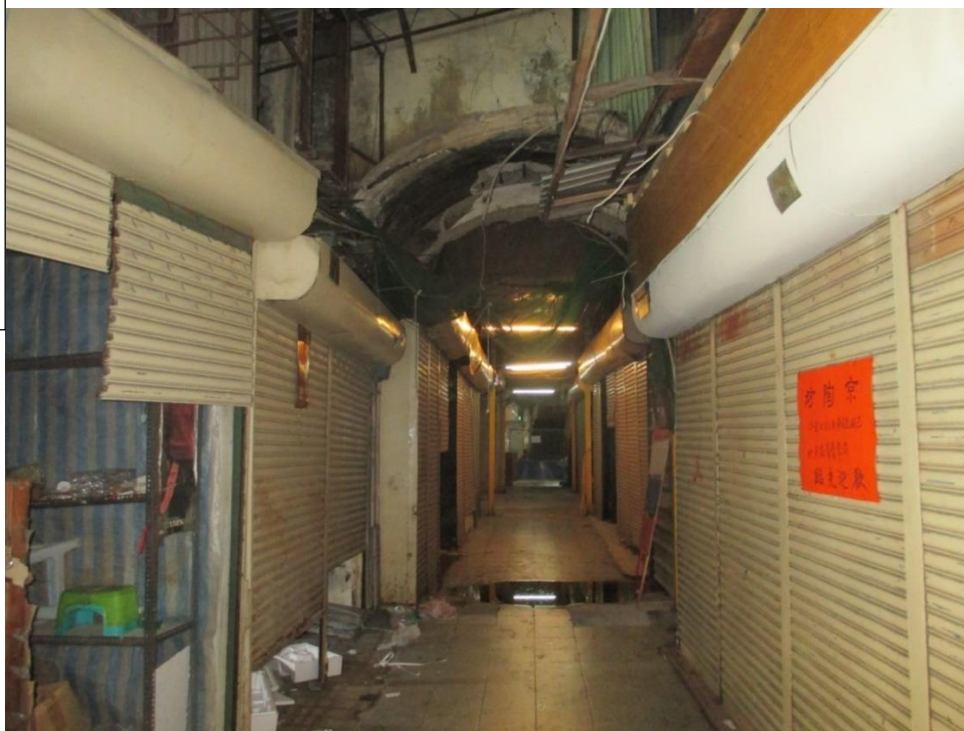
西市場本館-中央棟西南側立面入口修復前(20170531)
