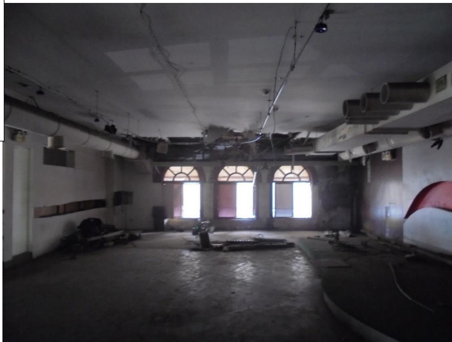
外廓賣店-中央棟二樓室內東北側修復前(20181109)
