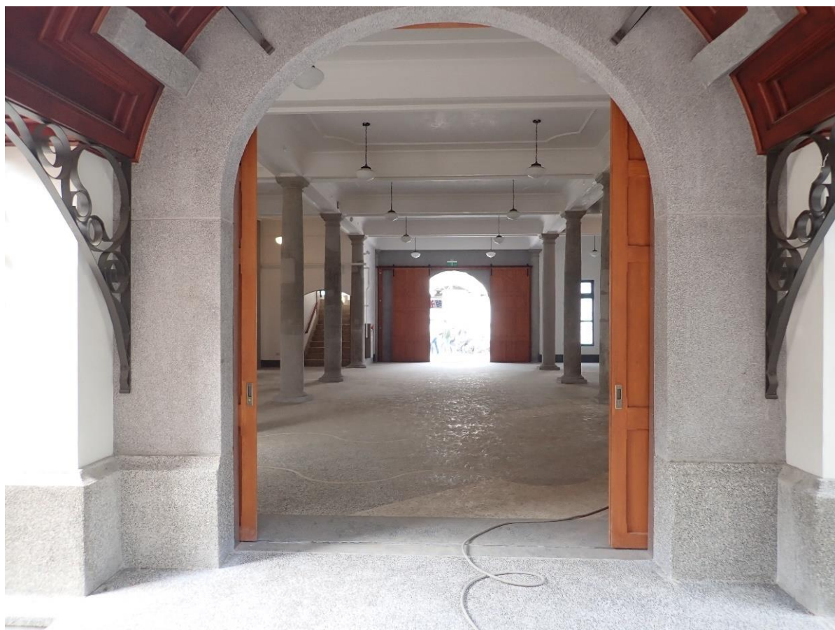
西市場本館-中央棟東北側正立面入口修復後(20210412)
