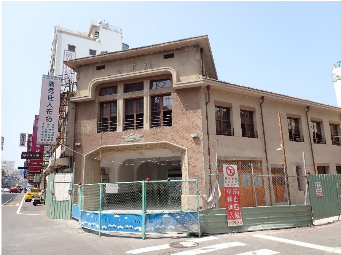
外廓賣店入口正立面修復後，一樓入口、二樓立面開窗、雨庇及上方原西市場字樣(20210412)
