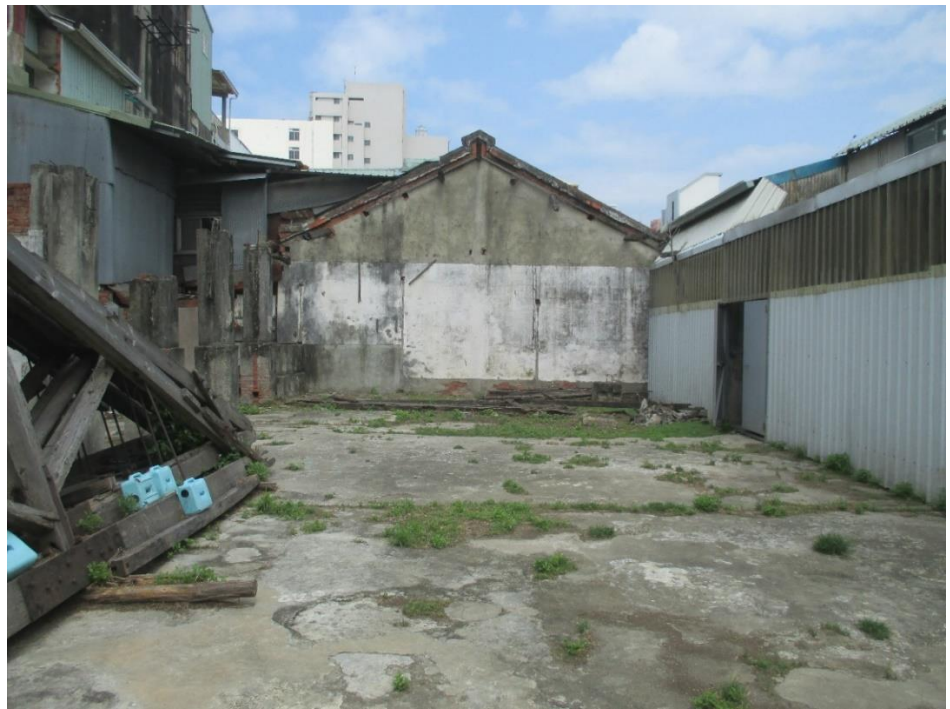
香蕉倉庫西側室內修復前(20170118)
