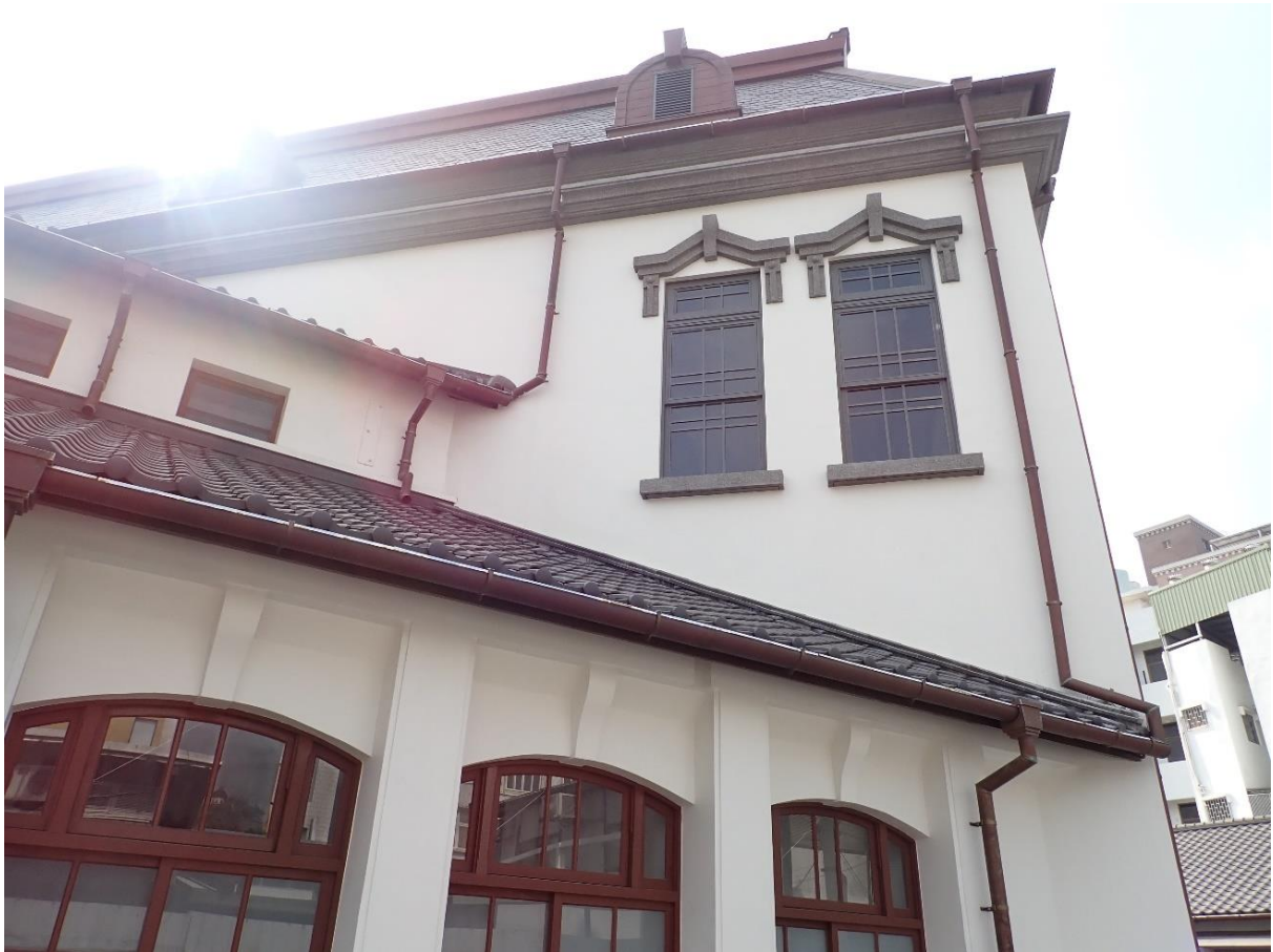
西市場本館-中央棟北側立面外觀一角修復後(20210412)
