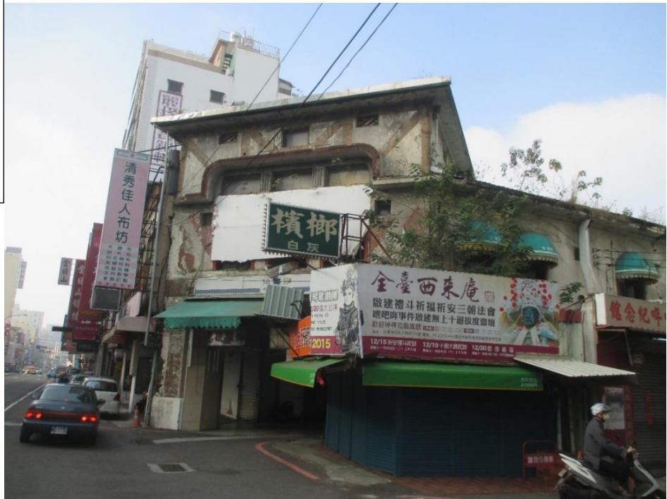
外廓賣店入口正立面修復前・立面遮蔽及不當改建(20181109)
