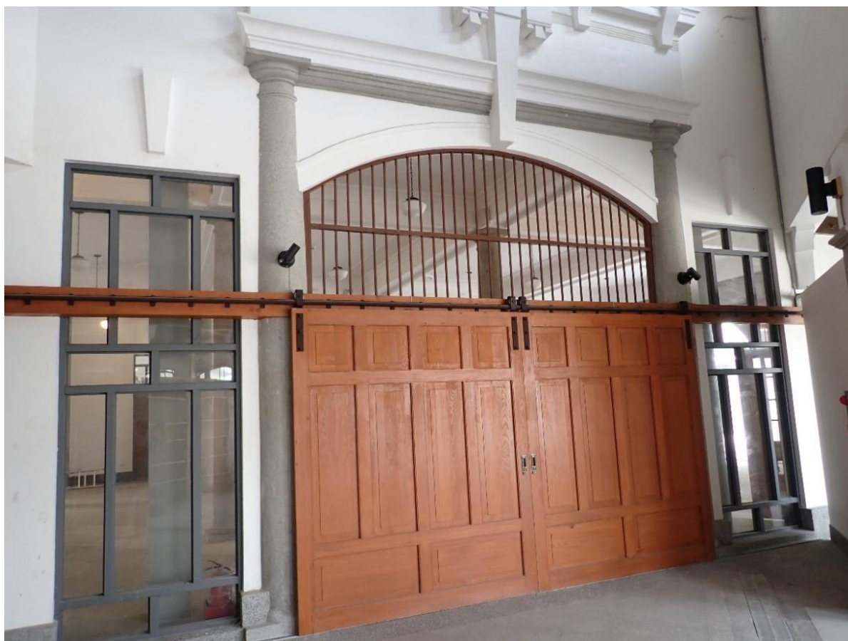
西市場本館-中央棟往北翼入口立面修復後(20210412)
