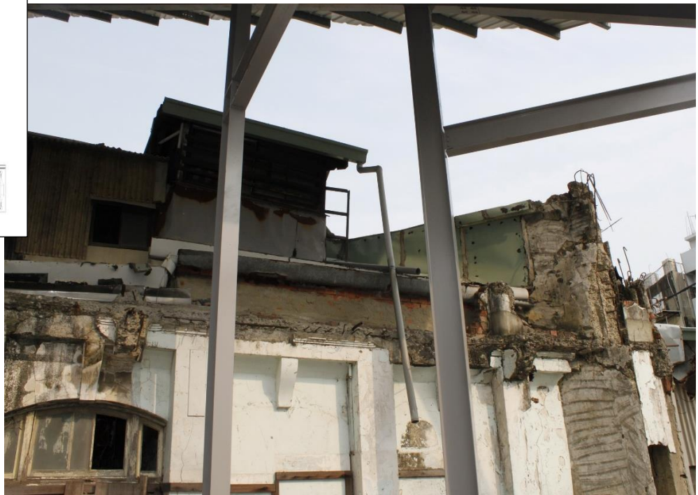
西市場本館-中央棟北側立面外觀一角修復前(20130306)
