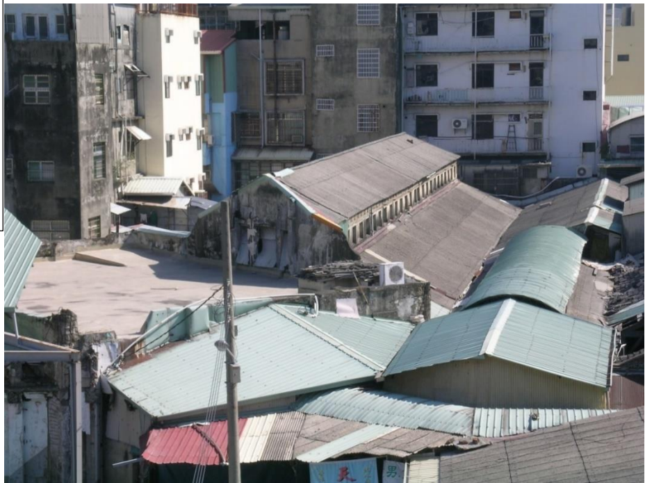
西市場本館-中央棟本館二樓立面外觀損壞清空修復前(20120605)
