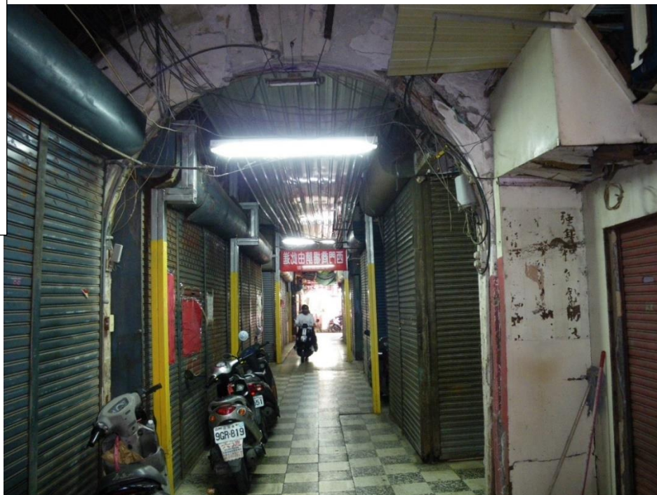
西市場本館-中央棟東北側正立面入口修復前(20090220)
