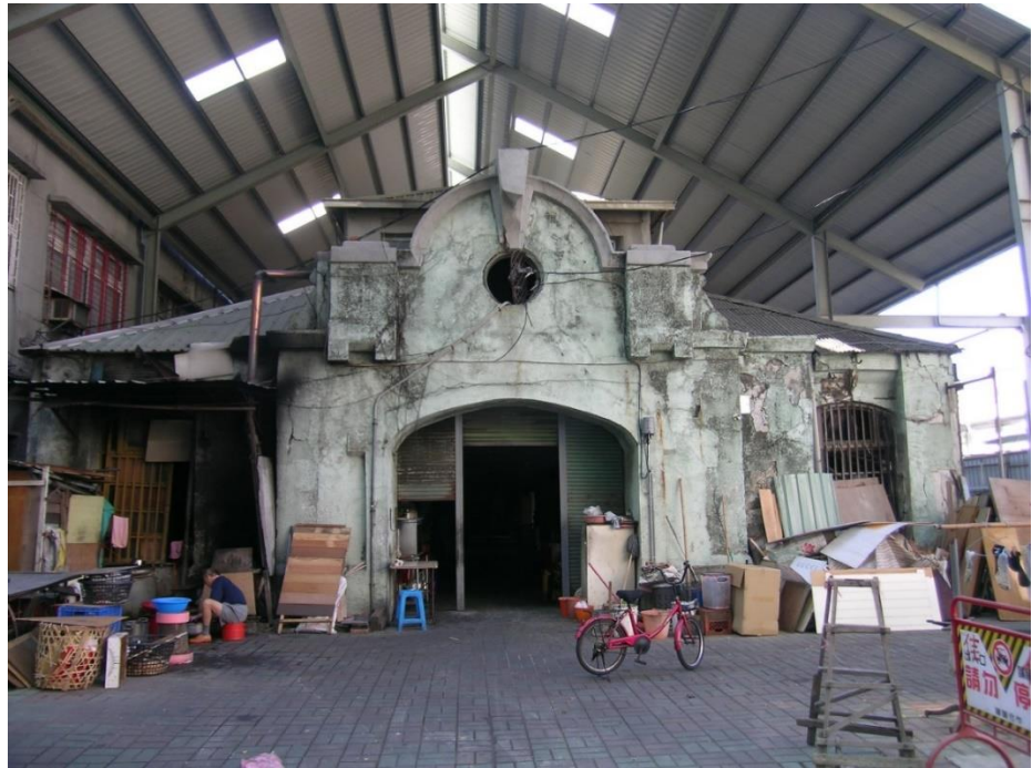
西市場本館-北翼北側出入口立面外觀修復前(20010101)
