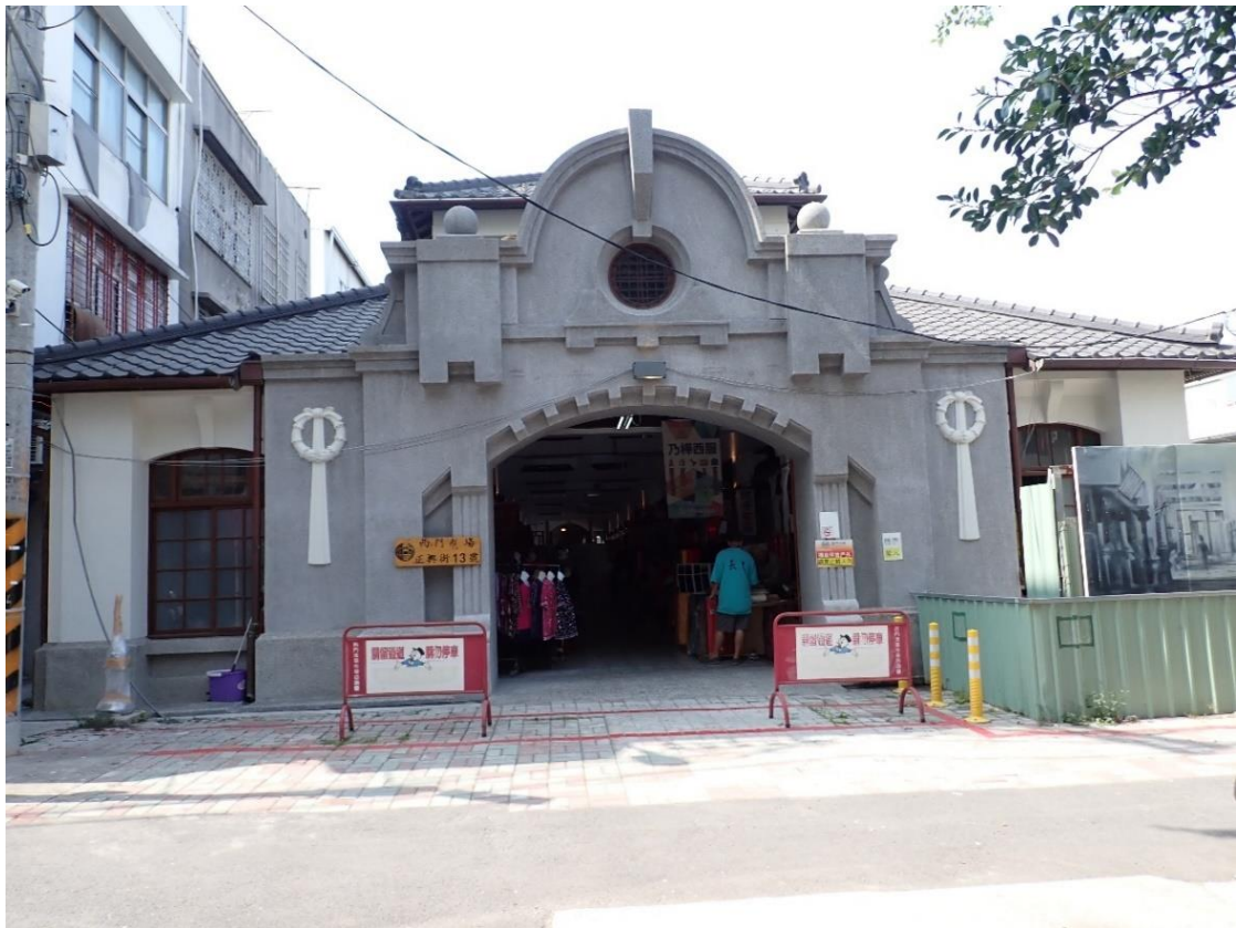
西市場本館-北翼北側出入口外觀立面修復後(20210412)
