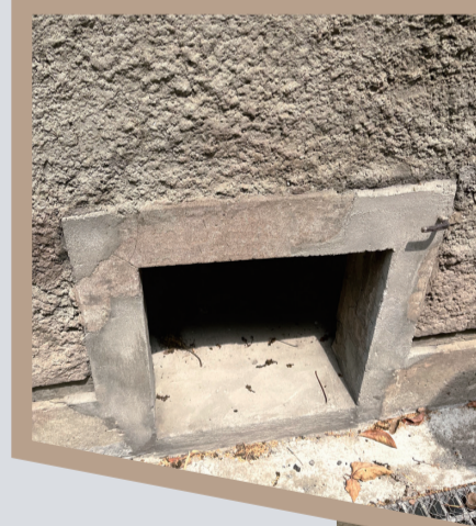
圍牆外側的方洞與內側箱體。
