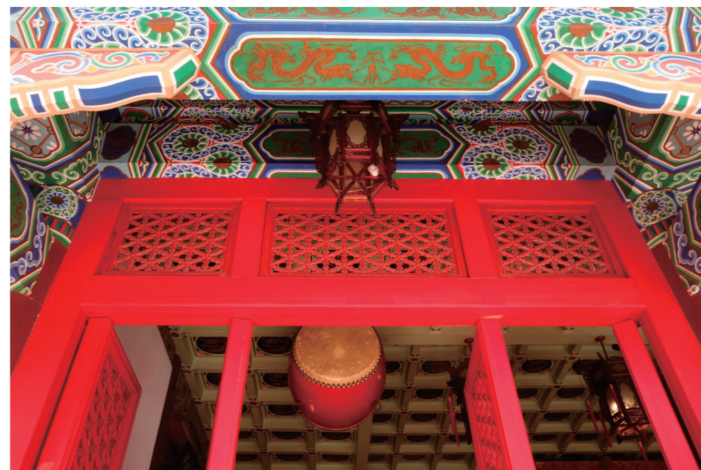
●延平郡王祠正殿格扇，三線交叉為「三交」，交叉線形成六個三角形稱為「六椀」。
