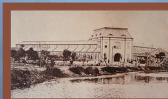
馬薩式屋頂最早起源17世紀法國建築師弗朗索瓦·馬薩（François Mansart）的設計，日治時期，被運用於許多臺灣大型公共建築，成為建築外觀視覺上的焦點，如：現今的臺南司法博物館、國立臺灣文學館、西市場中央棟。挑高的馬薩式屋頂，加上老虎窗、牛眼窗的設計，強化了建築內部空間的採光與通風，大幅提升使用的舒適性。
